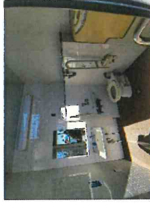
多目的トイレ内
